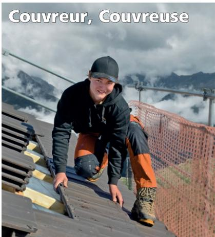
Assurer l'étanchéité et l'isolation des toitures inclinées dans des bâtiments neufs ou à rénover en posant des éléments de couverture (par exemple : ardoises, tuiles) et d'isolation contre le froid, l'humidité, la chaleur et le bruit.
