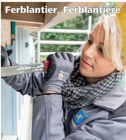
Façonner des feuilles de tôle ou de matière synthétique pour parachever l'étanchéité des toitures et des façades ou pour recueillir les eaux de pluie.
